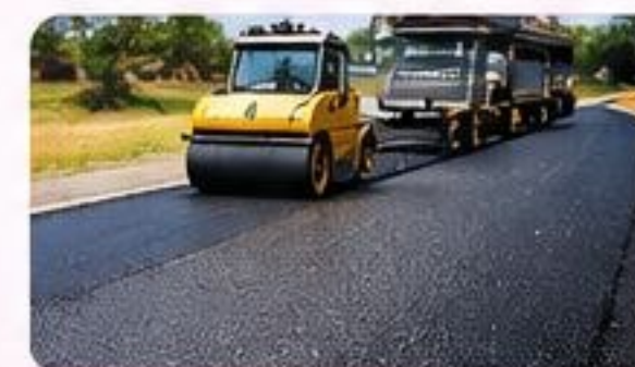
Yo'l qurilishida (asfalt)
